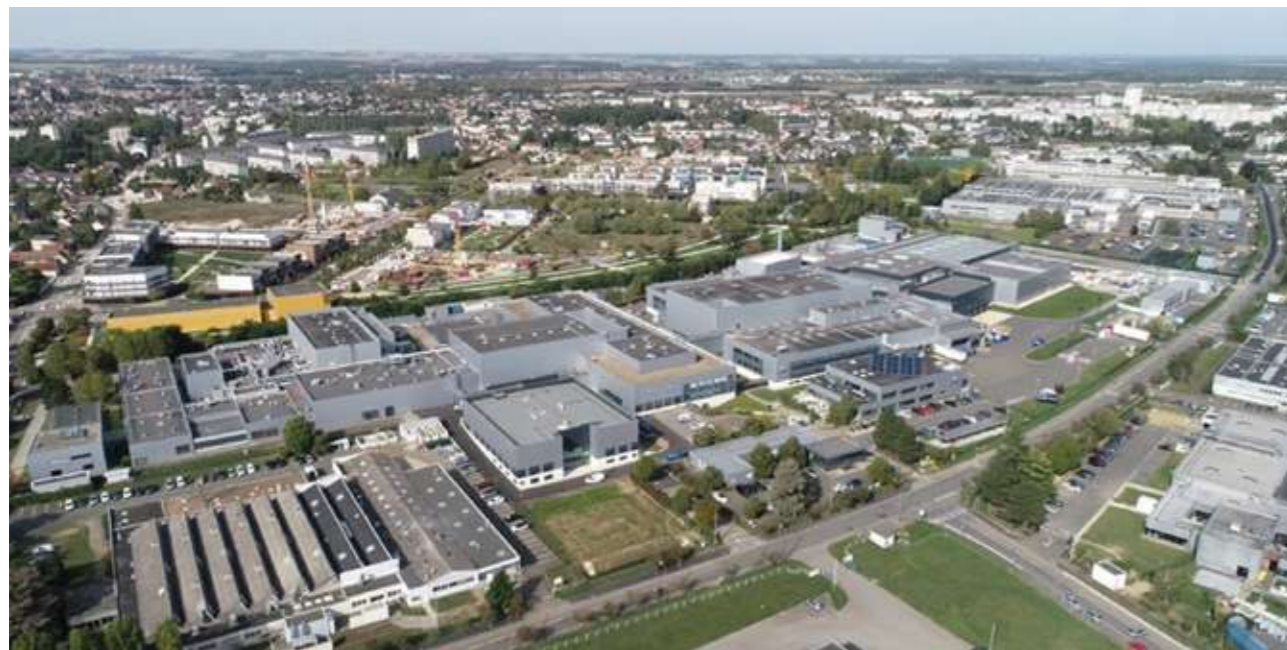
Vue aérienne du site de production Novo Nordisk à Chartres 2023.
