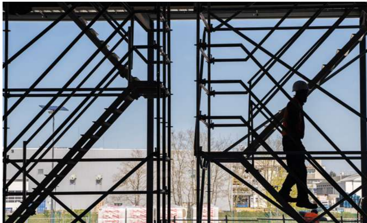
Illustration du chantier du bâtiment de produits finis FP3.
